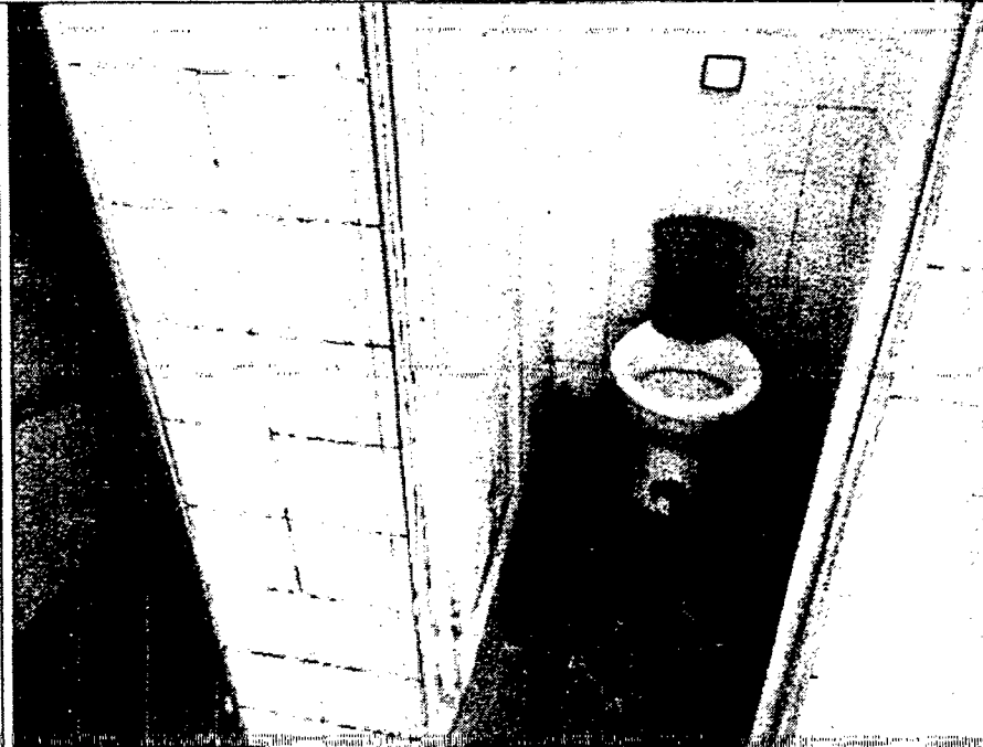
Descrição: BANHEIRO EXISTENTE- ESCOLA PADRE RAFAEL
